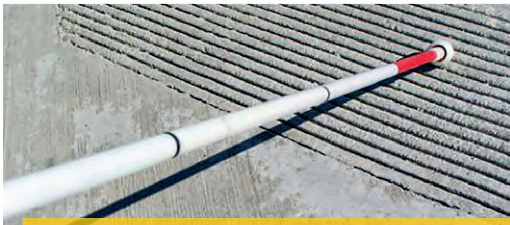
Taktiler Leitsystem, das mit dem Stock ertastet werden kann (Foto: BSVÖ)
